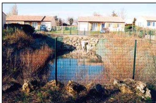
Bassin tampon dans le lotissement du Clone du Loup
